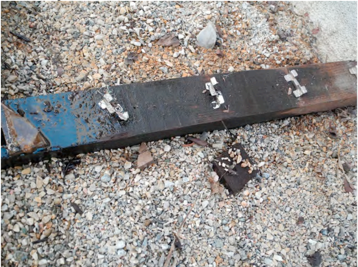
Unterkonstruktion nach Öffnen der Terrasse – Wetter regenfrei!
